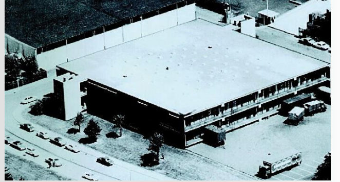
Yönetim ve depo binası 1968
